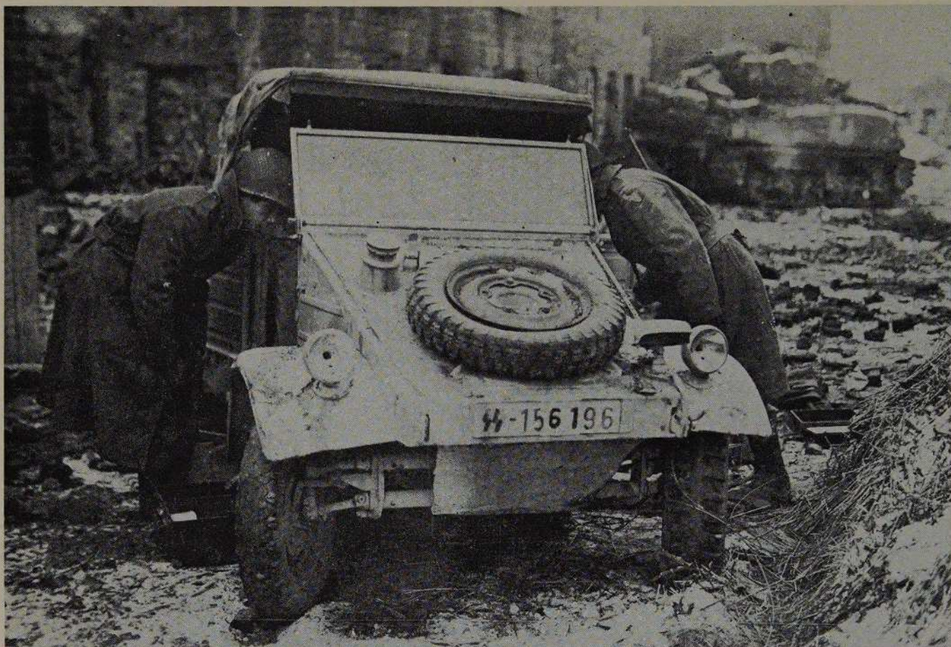
Amerikanische Soldaten bei der Besichtigung eines erbeuteten deutschen Kübelwagens. Bezeichnend für den Gummimangel in Deutschland ist, daß der Wagen mit drei verschiedenen Reifentypen ausgerüstet ist.
